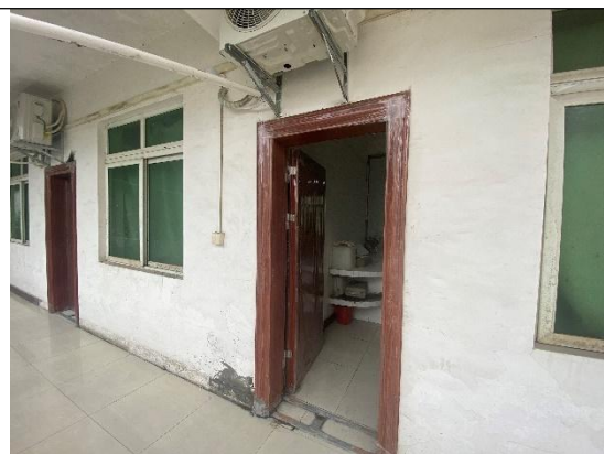
化学实验间储存室 1
